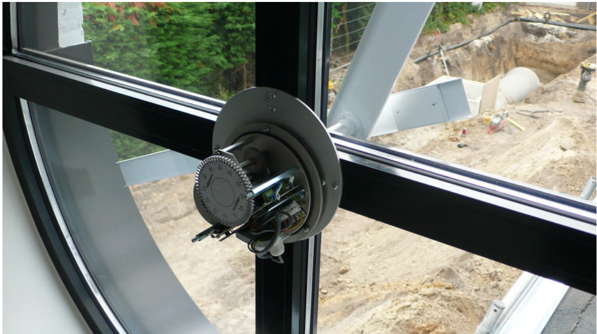
Afbeelding HSV1 zonder afdekkap. Pulsgever: SR290DH, zie onder moederklokken.
